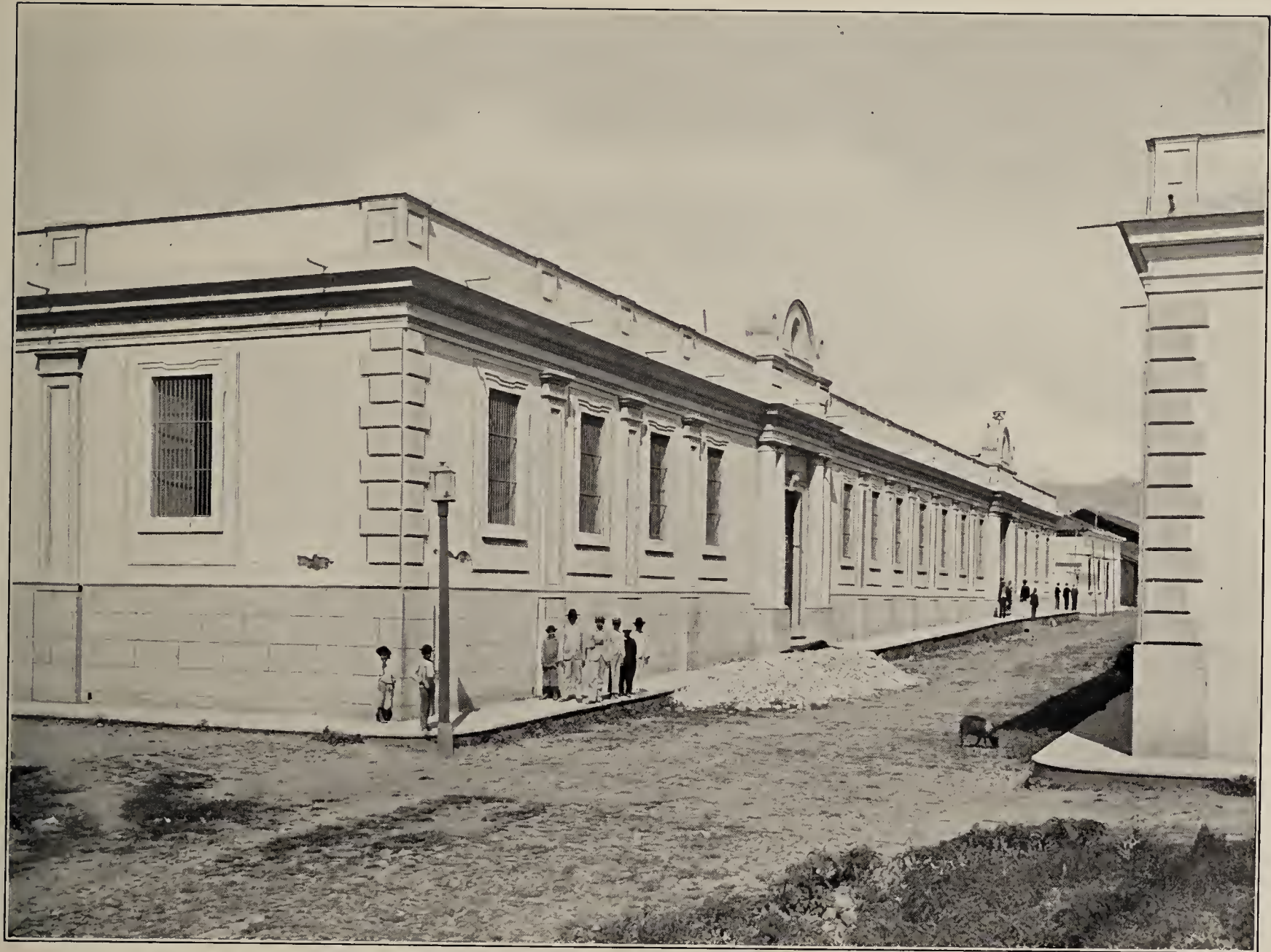
Una vista del Hospital General.—TEGUCIGALPA
